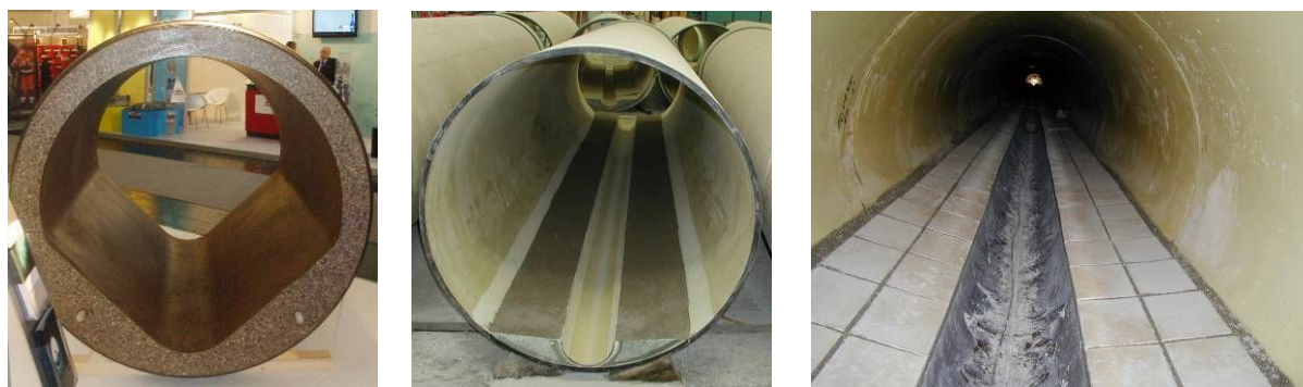
Obr. 4.5 Příkladů úpravy dna propustku
